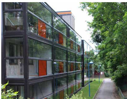
Renovering av lägenheter i den femte etappen i Rinkeby.
