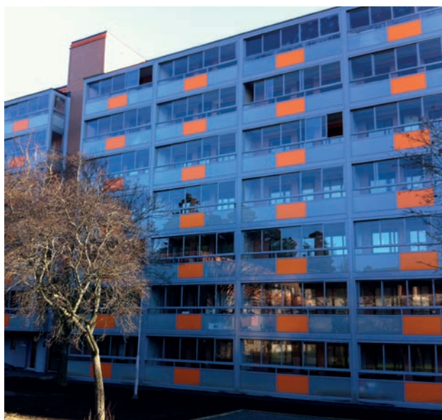
81 lägenheter i Rinkeby har genomgått en totalrenovering.
