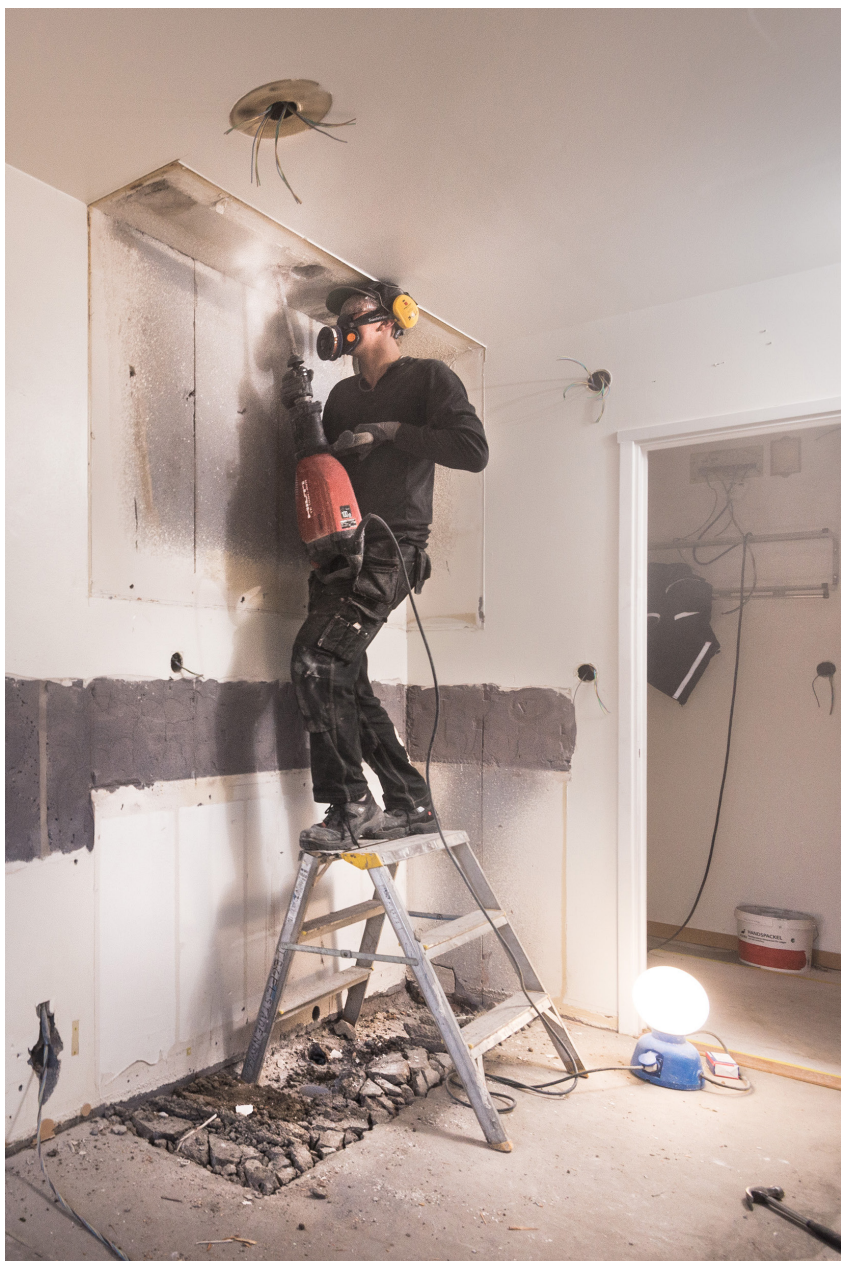
Projektet innefattar ett omfattande arbete. Bl.a. kommer alla befintliga kök att rivas och helt nya monteras in. Foto: J. Lindblad
