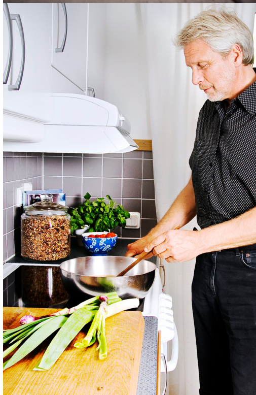
Även det befintliga köket rivs ut i sin helhet. Helt nya vägg- och bänkskåp monteras. När allt är klart har du ett nytt och modernt kök i ljusa och trevliga färger Foto: J. Lindblad / Victor Gårdsäter
