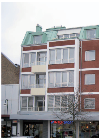
Gjutaren 9, Eslöv. Fasaden och balkongerna renoverade.
