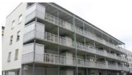
Kv Gråtruten, Gällivare. 16 hyresrätter. Färdigställt år 2009.
