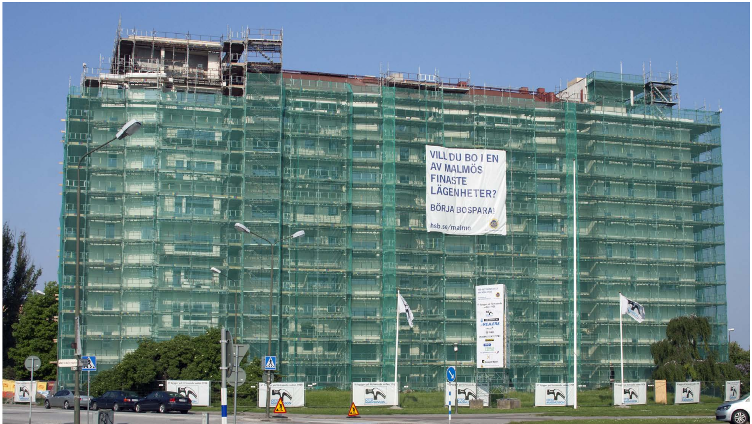
Bakom byggnadsställningarna döljer sig ett av Sveriges finaste funkishus. Restaureringen beräknas pågå till nästa sommar.
