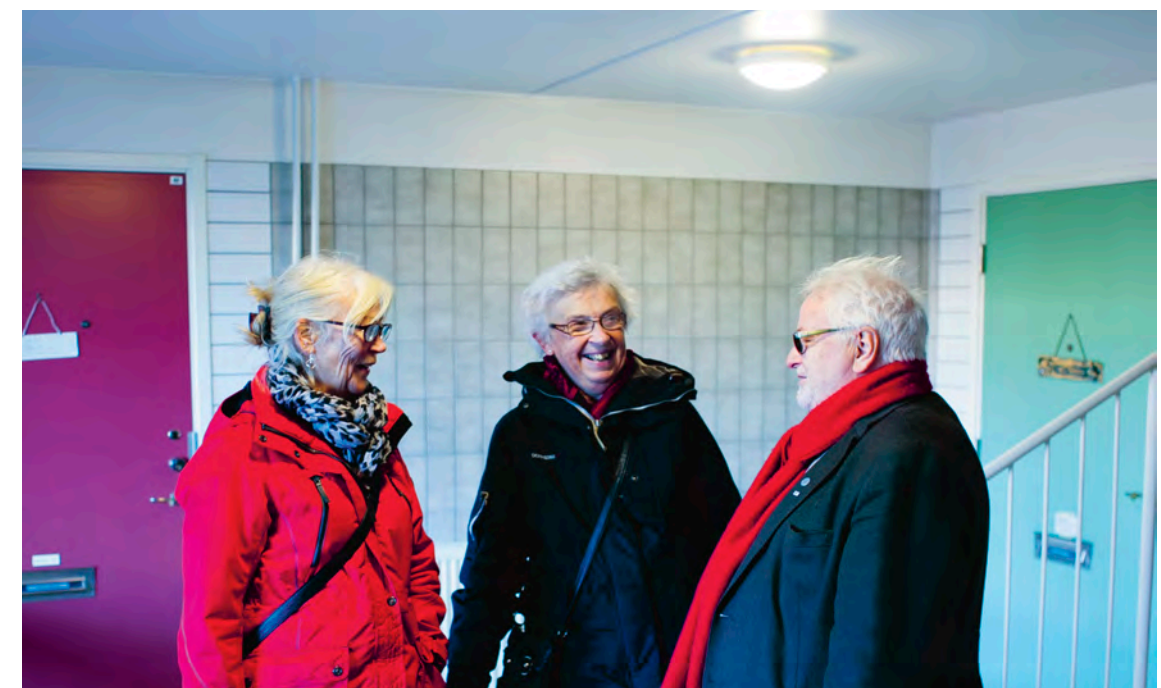
Jorun Borgen, Marianne Bengtsson och Jan Linde är väldigt nöjda med de energisnåla LED-armaturer som har installerats i brf Skinnefjäll i Mölnlycke.
