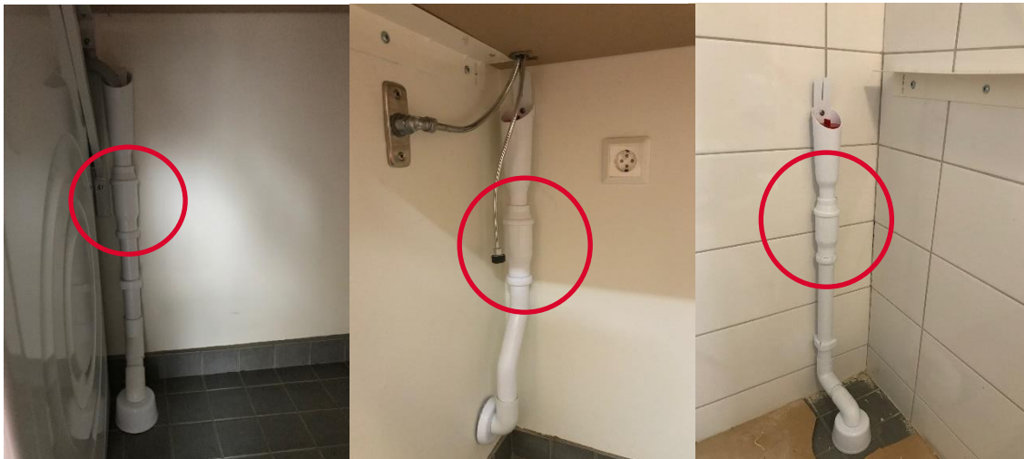
Bild 1.1. Placering av vattenlås.
