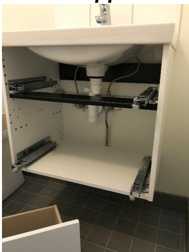
Bild 2.1. Placering av vattenlås.
