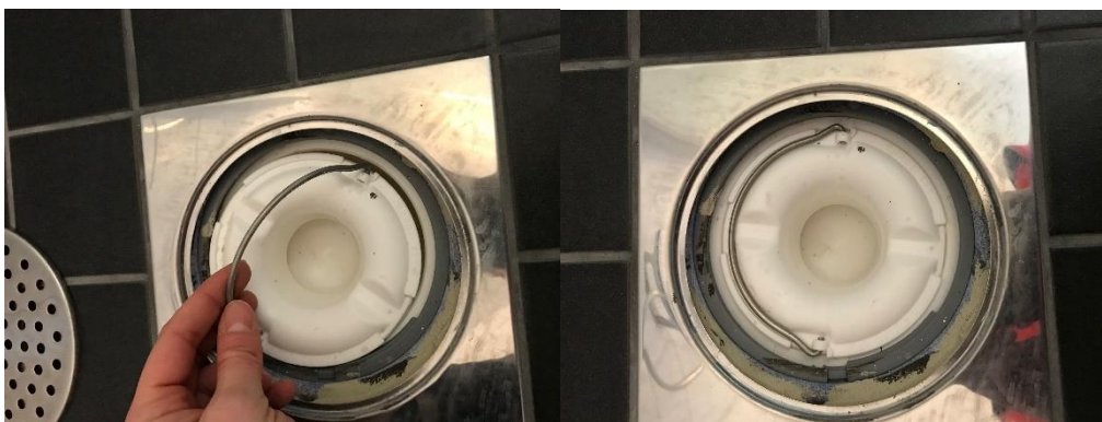
Bild 3.2. Sätta tillbaka vattenlåset.
