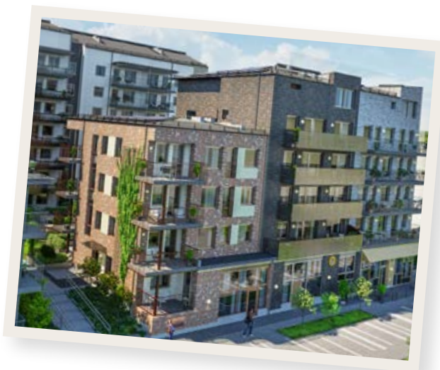
HSB Parketten är det HSB-projekt som byggs först på Skeppsbron och utgörs av hyresrätter.
