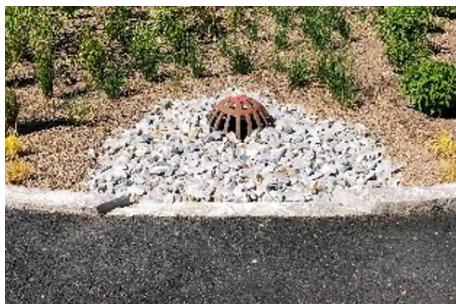
Fel placering av bräddbrunn vid inlopp och underdimensionerat, insatt inlopp
