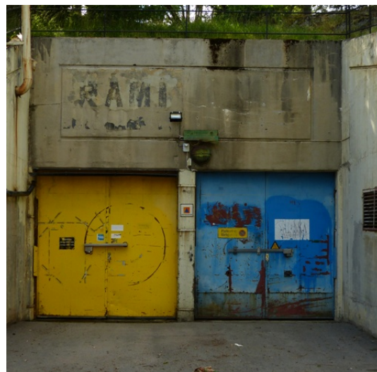
Infarterna till de två olika våningsplanen i bergtrummet
