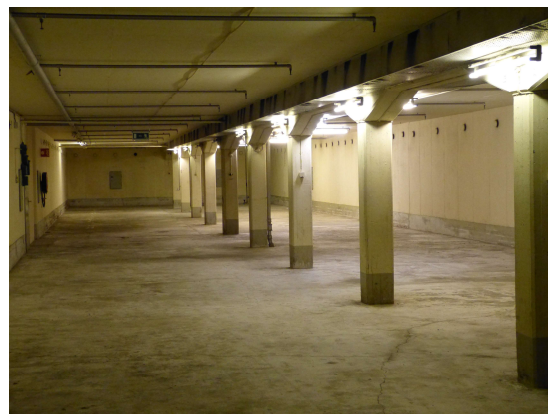
Ett av många stora utrymmen i bergtrummet
