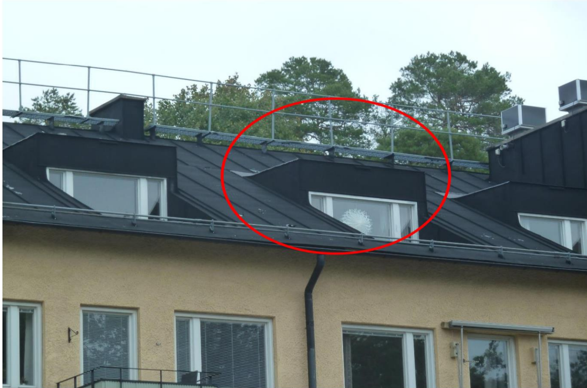
Bild 1. Låglutande tak på kuporna.
