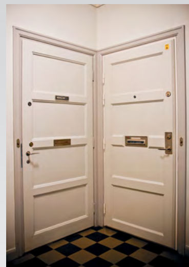
Befintlig dörr till vänster, och ny säkerhetsdörr till höger producerad efter den gamla dörrens design.
