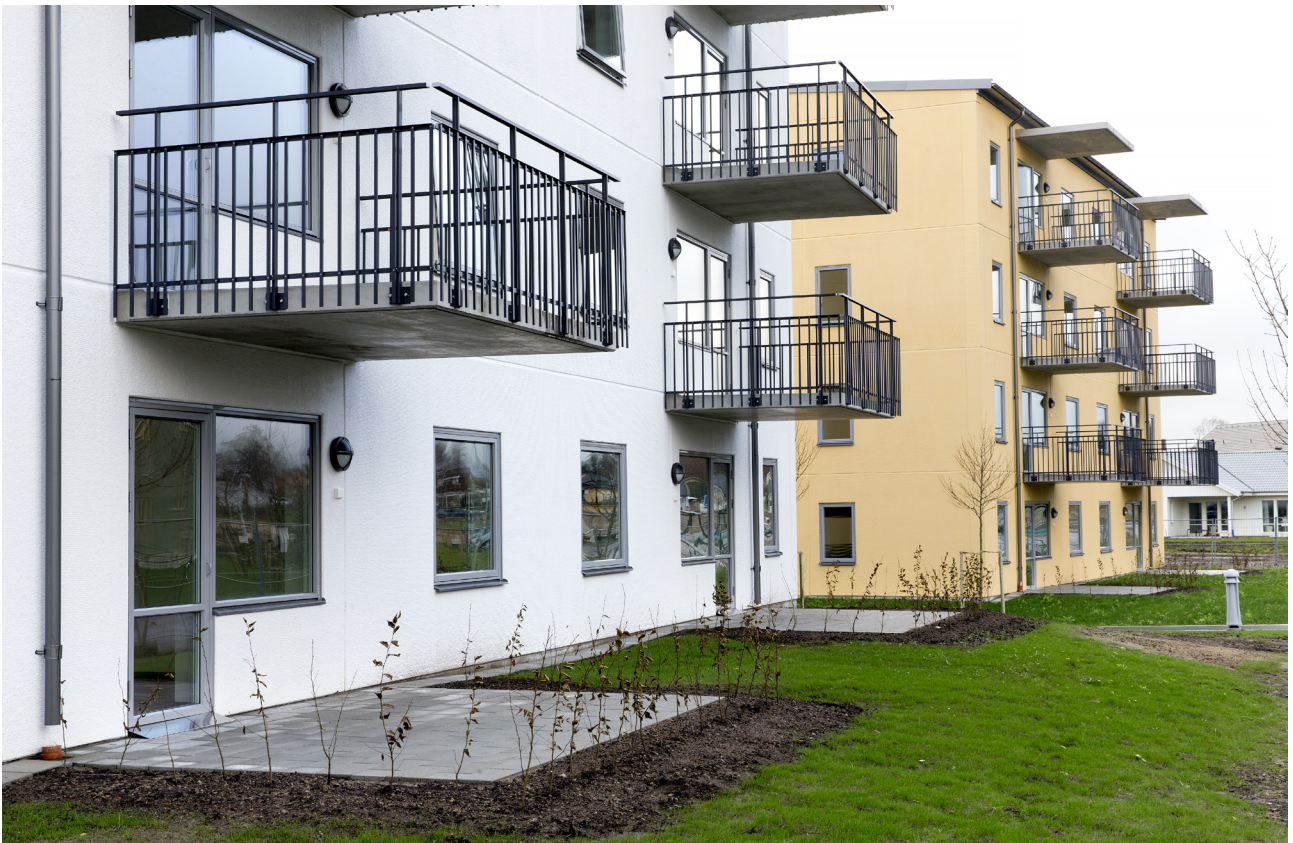
SABOs Kombohus Bas på bilden är byggt av allmännyttiga Halmstads Fastighets AB.
