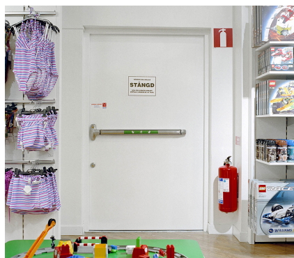
Säkerhetsdörr med panikregel, magnetkontakt och mikrobrytare i lås är en vanlig syn i butiker
