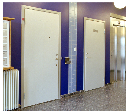
Säkerhetsdörr S33 och ståldörr S30 har samma fasade överfals och fungerar därför bra tillsammans när det krävs olika klassningar.
