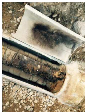
Eternit kulvert i mark från 1956. Brf Sparrhornet II
