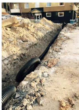
Kulvert grävs upp och byts Brf Sparrhornet II
