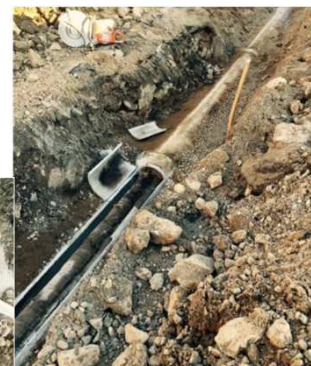
Eternit kulvert i mark från 1956. Brf Sparrhornet II
