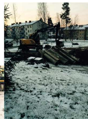
Kulvert grävs upp och byts Brf Sparrhornet II
