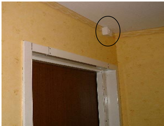
Bilden visar ett uttag monterat ovanför ytterdörren.
