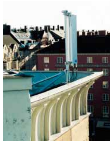
Antenn på basstation för 3G.
