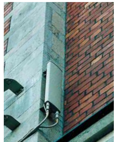
Antenner på två olika basstationer för 3G.
