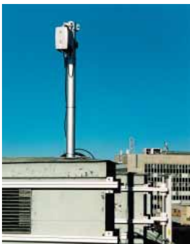
Antenn på basstation för 3G.
