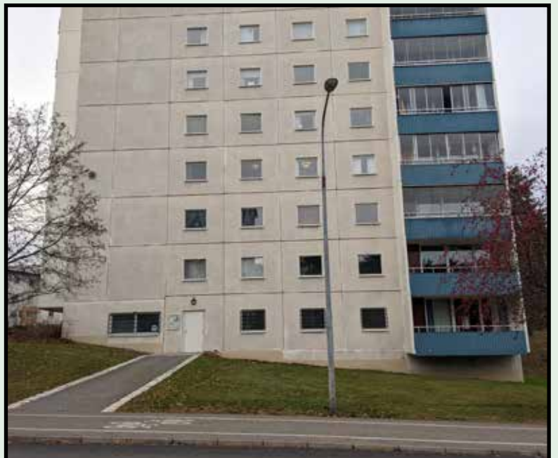
Brf Östbergas föreningslokal på Stamgatan 89
