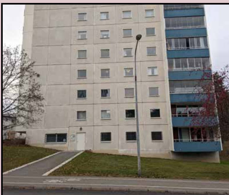
Brf Östbergas föreningslokal på Stamgatan 89
