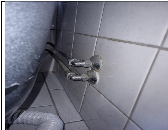
Rör genomföringar i plats för badkar
