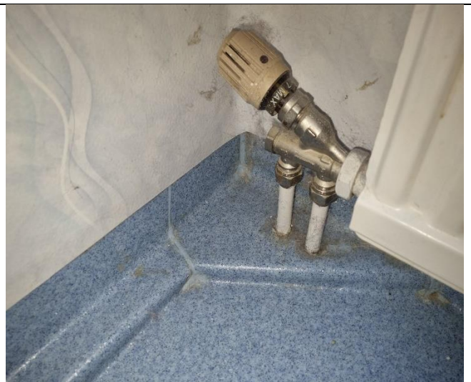
Rör genomföringar i golv.
