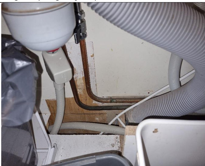
Otät skåpsbotten, kan ta lång tid innan en vattenskada upptäcks.
