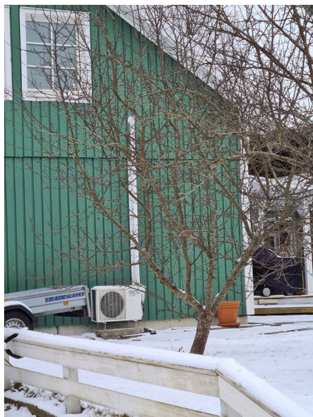
Figur 1. Exempel på installation av luftvärmepump på övervåning, där utomhusdelen är placerad på markplan. Detta möjliggörs genom att kablage och slang dras på sidan av väggen.
