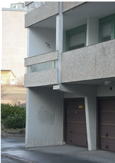
Hus A, ytterbåge Väggdel/ gavelstycke bevaras
