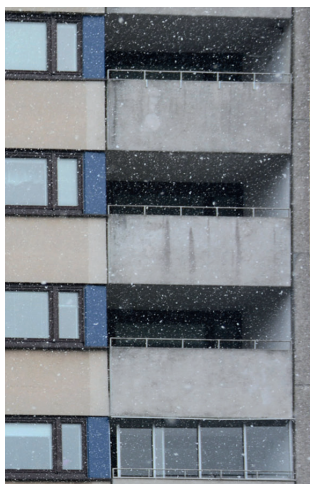
Hus B, Innerbåge Foto: Befintliga balkonger typ B4 Ytterkant balkongfront i samma liv med fasad
