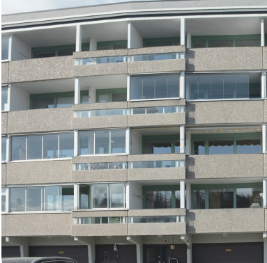
HUS A, Ytterbåge Typ A1, A1(S) Utstickande balkong, natursten/betongfront, vägg mellan balkonger, pelare mitt i balkongen, pelarkonsol på marken
