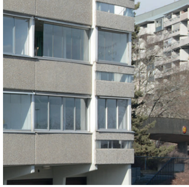
HUS A, Ytterbåge Typ A2, A2(S) Utstickande balkong, natursten/betongfront, vägg mellan balkonger, pelare mitt i balkongen, pelarkonsol på marken
