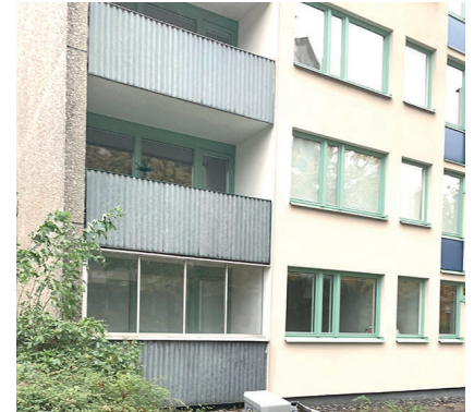
HUS A, Innerbåge Typ A3, A3(S) Indragen balkong, gabonplåtfront, balkongfront i liv med husfasad
