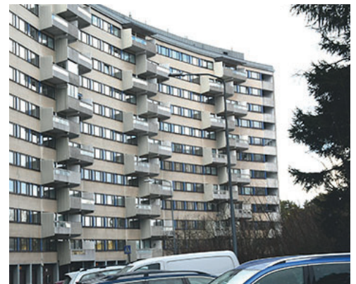
Hus B, Innerbåge Foto: Befintliga balkonger Indragna balkonger typ B4 Utstickande balkonger typ B3, B3(S)
