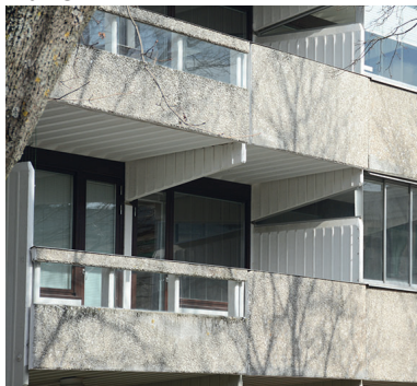
HUS B, Ytterbåge Typ B1, B1(S) Utstickande balkong, natursten/betongfront, rillor under balkongplattor, skärmvägg av betong, konsol av betong mitt under balkongplattor
