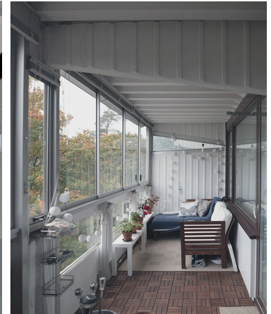
Hus B, Ytterbåge och innerbåge, Foto: Befintlig utstickande balkong: Skärmvägg av betong, rillor under balkongplattan, räcke, varierande typer av inglasningar finns
