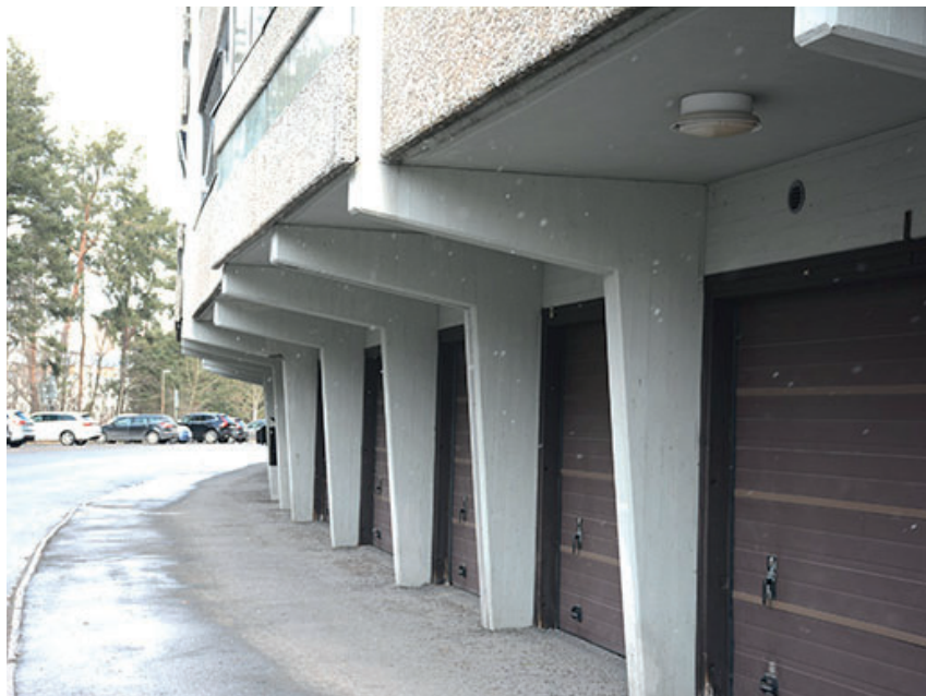
Hus A, ytterbåge Befintliga pelarkonsoler bevaras
