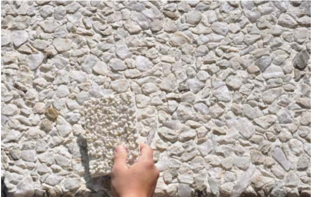
Bild 24. Steniprov med rätt kulör mot djuptvättad balkongfront visande trolig ursprungskulör
