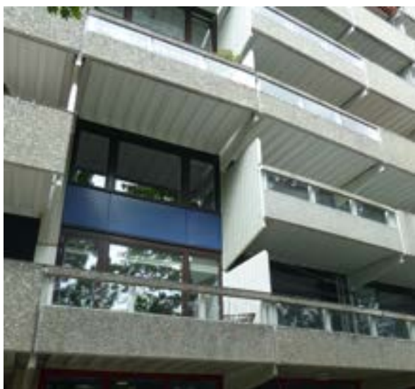
Bild 26. Balkongundersidor med ribbstruktur
