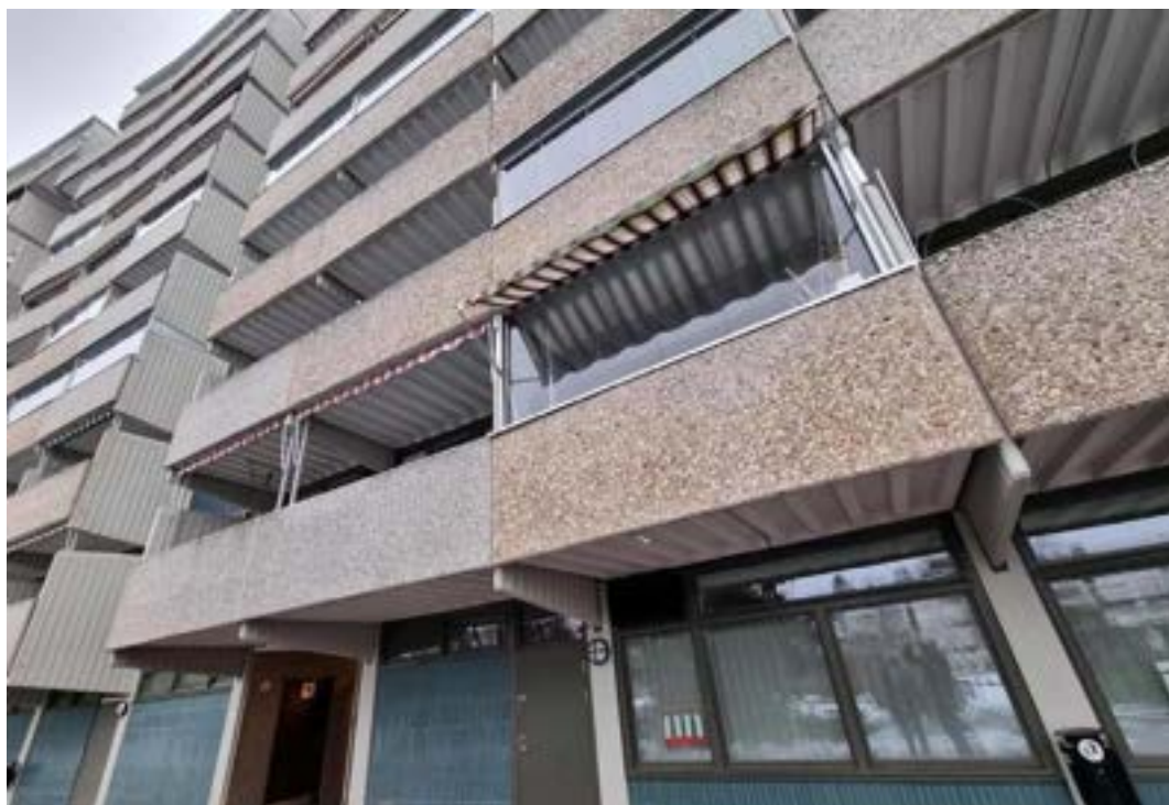
Bild 22. Fronterna på BFR Jupiters höghus har inga fasta glasband. Här ser man även en tydlig skillnad mellan ursprungliga och ersatta balkongfronter
