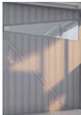
Bild 33. Ett platt stag bär balkongplattan. Illustration Gisselberg Arkitekter
