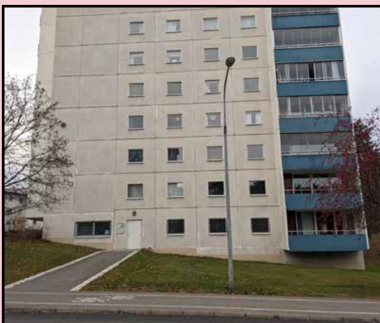
Brf Östbergas föreningslokal på Stamgatan 89
