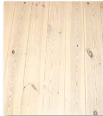
Originalgolvet renoverat och reparerat på Ahlströmergatan 32 B.
