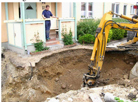
Byte av avloppsrör på Sörgården utanför port 10.
