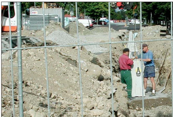
Här pågår fullt arbete på de nya parkeringsplatserna
