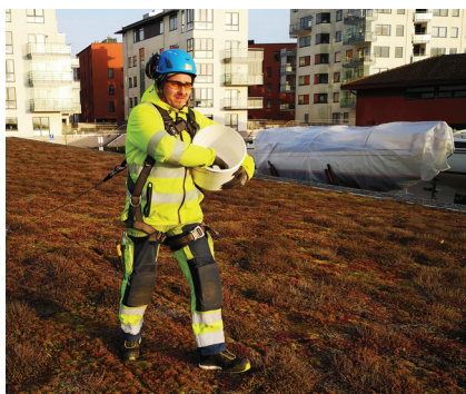
Gödsling av sedumtak.
