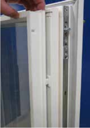
Vid delning av koppelbeslag, dra aluminiumbågen från träbågen.
