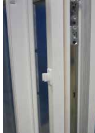
Vid sammankoppling av koppelbeslag, tryck aluminiumbågen mot träbågen.
