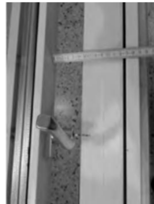
Fig 37. Utfällssäkringen skall låsa bågen så att inlåt mätt inte överstiger 10 cm.
