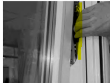
Fig 36. Spärren på beslaget förs mot rummet för öppnande av fönstret.
