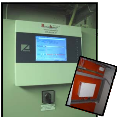
Elektroniken som styr alla signaler för ventilationsaggregatet, bakom displayen döljer sig "hjärnan"
