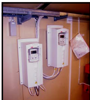
Dom här burkarna håller reda på fläktmotorerna
