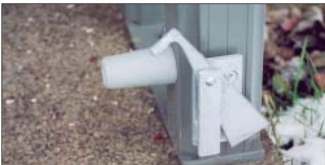
Ett dörruppställningsdon, en s.k sparv
