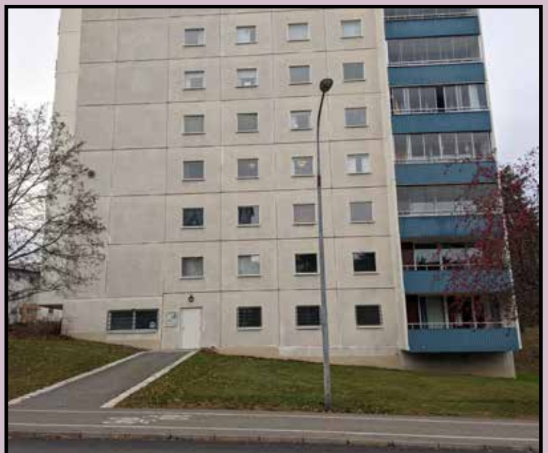
Brf Östbergas föreningslokal på Stamgatan 89
