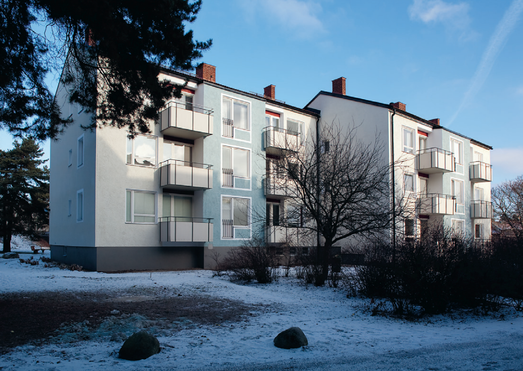
De sammanlänkade och sinsemellan förskjutna byggnadskropparna, i området kring Götaforsvägen i södra Stureby, är på ett tidstypiskt sätt glest utplacerade i ett halvöppet parklandskap. Foto: Johan Stigholt, Stockholms stadsmuseum.
