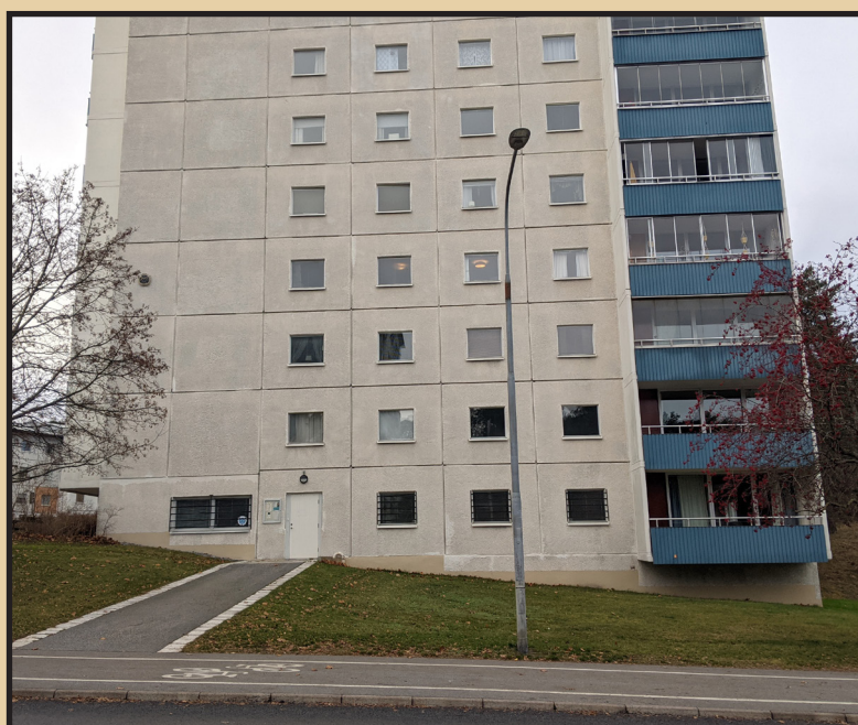
Brf Östbergas föreningslokal på Stamgatan 89
