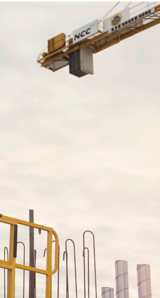
I Linköpings nya stadsdel, Södra Ekkällan, pågår uppförandet av projektet Rosenkällan. 47 lägenheter är planerade och inflyttning beräknas ske under hösten 2011.
