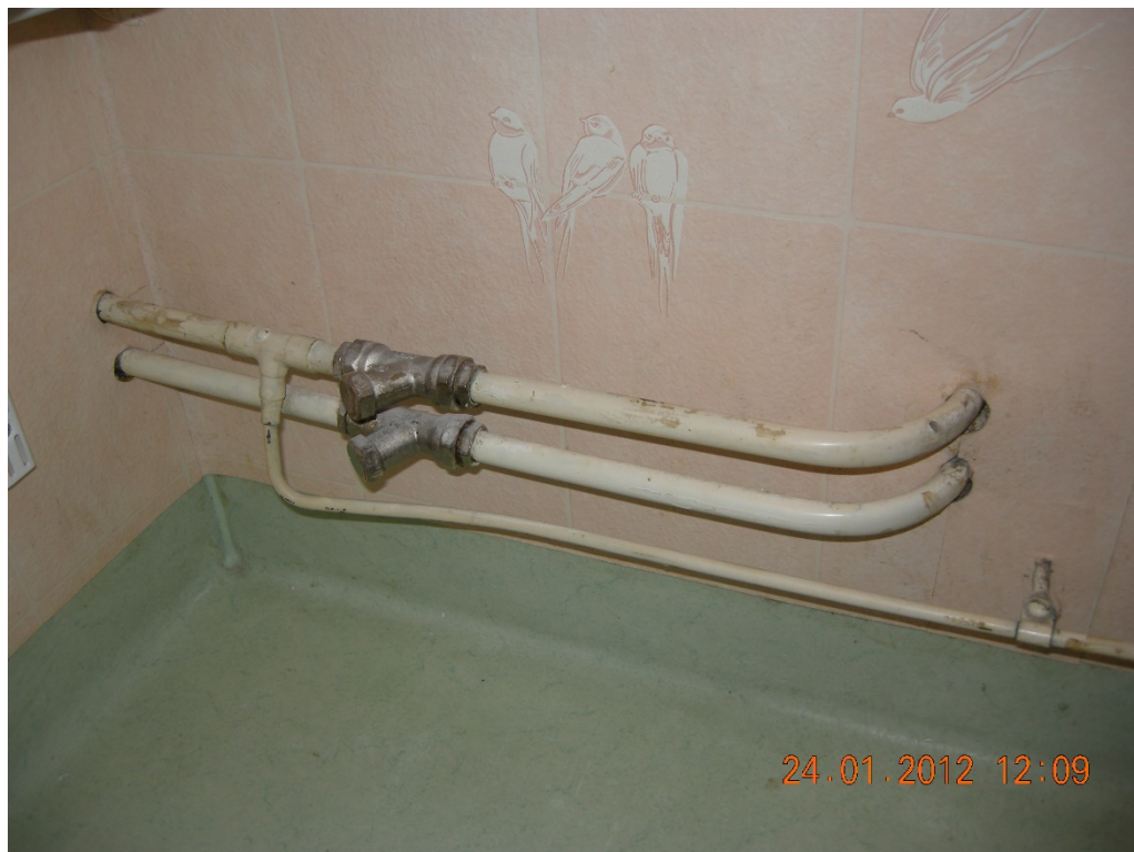
Osäkra avstängningsventiler
