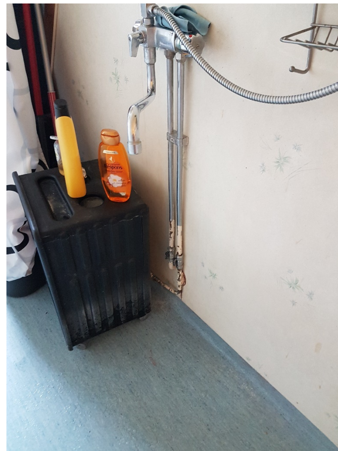
Rör genomföring ned- till i vägg i våtzon 1
