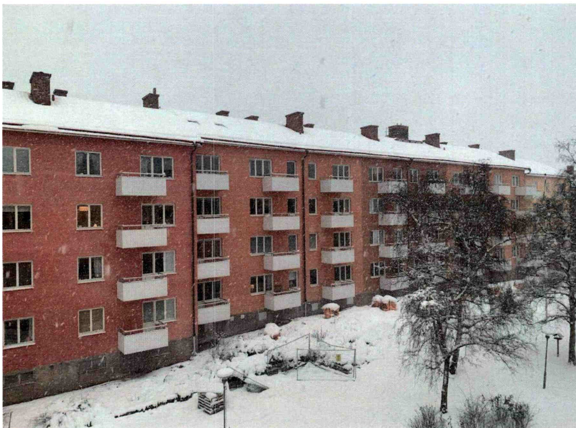
Föreningens nya fasader Vapengatan 3 - 11
