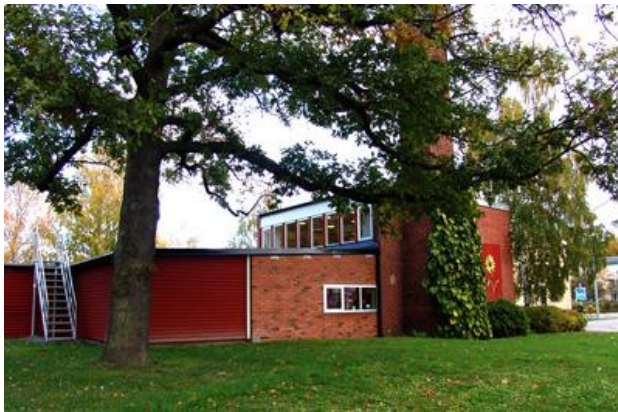
Panncentralen utifrån, med blickfånget på den ståtliga övervåningen
