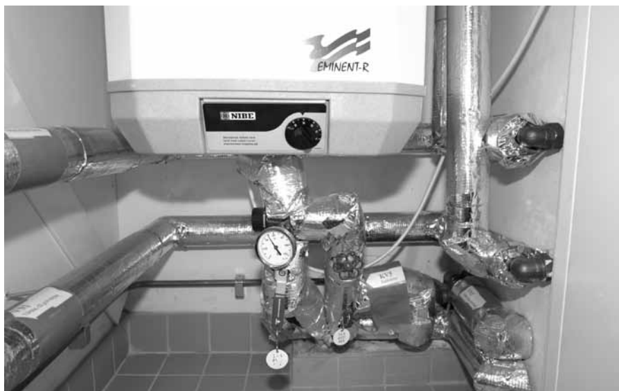
Säkerhetsströmbrytare, värme. Ska normalt vara "på". Cirkulationspump. Ska stå i läge III.
