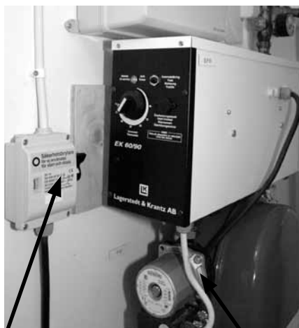
Säkerhetsströmbrytare, värme. Ska normalt vara "på". Cirkulationspump. Ska stå i läge III.
